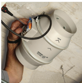
Realizar las conexiones.
