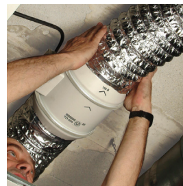
Acoplar los conductos.
